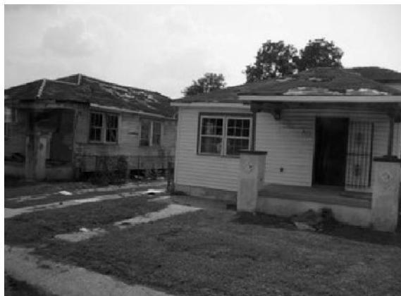
放置された状態の建物
