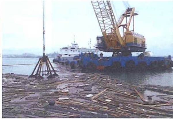
▲石巻港 流出した木材の除去
