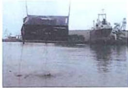
▲仙台塩釜港 沈んだコンテナの引き上げ除去
